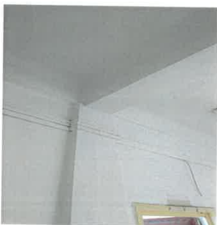
Foto: stalp central pe care reazema grinzi longitudinale si transversale din beton armat
