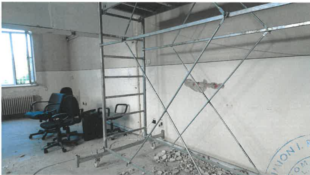
Foto : dezvelirea zidului in dreptul unei grinzi principale transversale in care se vede absenta unui stalp din beton armat corespondent
