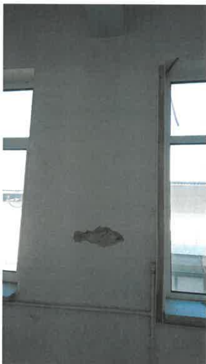
Foto : sondaj cu stalp din beton armat in grosimea zidului exterior
