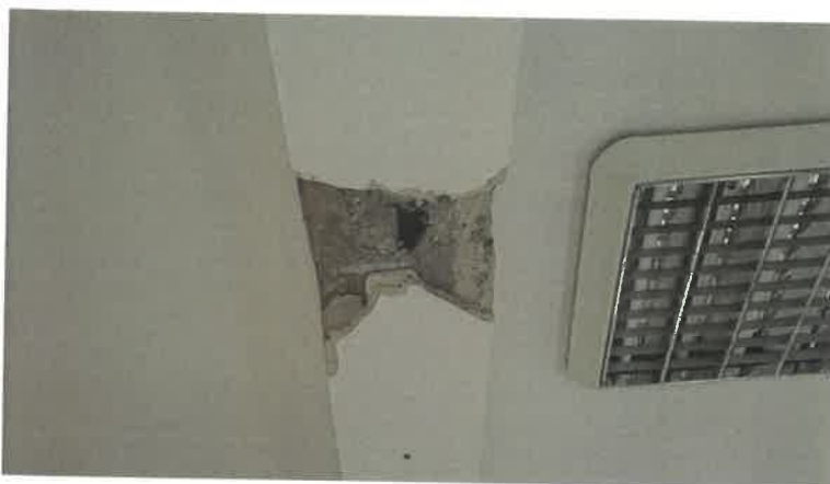
Planșeu din lemn peste etaj, cu fisuri în tencuiala
