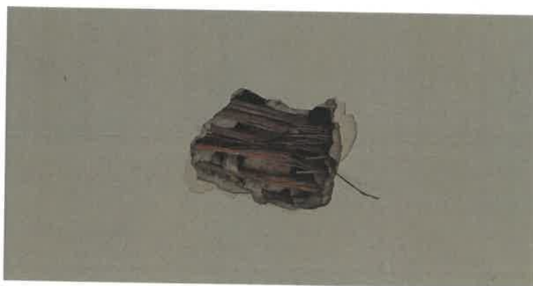
Planșeu din lemn peste etaj, cu fisuri în tencuiala
